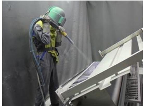
איור 2 : ניקוי חול http://ferroecoblast.com/r_d/sand_blasting_and_shot_blasting/
