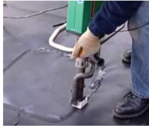
הלחמת אקסטרוזיה. המקור: TWI Ltd.
