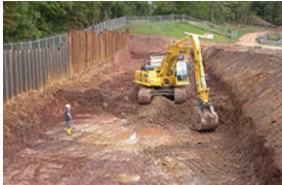
חפירות פתוחות. המקור: RK Company. Open Excavation. http://rkandcompany.com/open-excavation/
