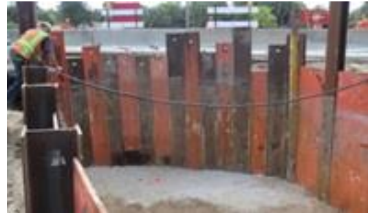
דיפון תעלה באמצעות יריעות מתכת. המקור: Trench Shoring Services. Shoring & Trench Sheets. https://shoring.com/products/shoring-sheets/
