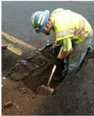
חפירת חור בדיקה. המקור: Interlaken . Rose City Rehab Potholing.
