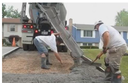
יציקת בטון ממשאית (מערבל בטון). המקור: Sciulli Concrete. How to Pour a Concrete Driveway.
