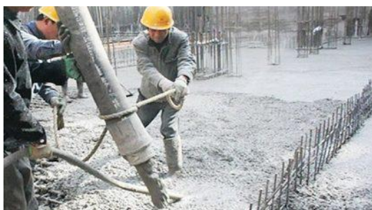
יציקת בטון באמצעות מערכת שאיבה. המקור: Orazio.it. Antifreeze Admixtures for Concrete during Cold Weather Concreting.
