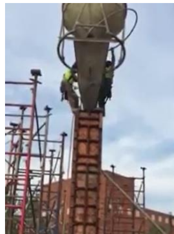
יציקת בטון לתוך טפסות עמוד באמצעות עגורן צריח. המקור: J. McKnight. Tower Crane - Pour Concrete Columns.
