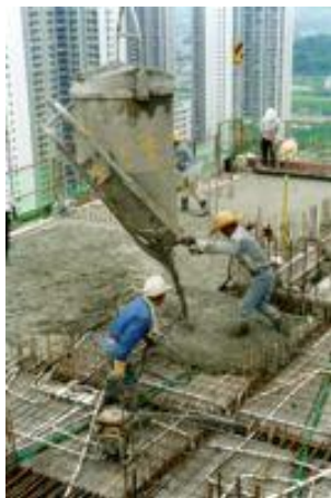
יציקת בטון על מישור באמצעות דוד בטון הקשור לאונקל של עגורן צריח. המקור: CIVCAL. Placing Concrete.
