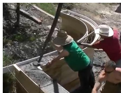
יציקת בטון לתוך טפסות. המקור: D. Humpherys. Spider Tie Monolithic Concrete Wall Instructional Video.
