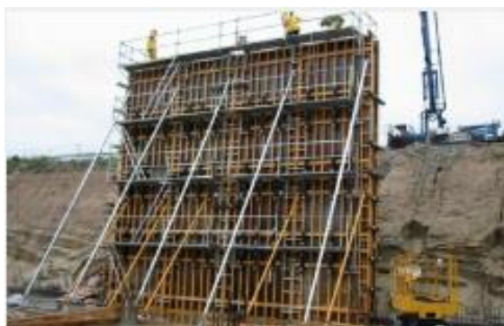
תפסות קיר. המקור: ULMA Formwork and Scaffolding for construction sites.
