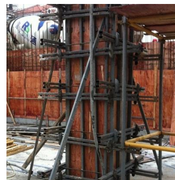
תפסות עמוד. המקור: XMWY. Alibaba.com. Group. Table Plastic Formwork Scaffolding System.
