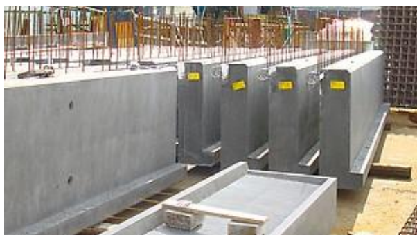
אחסון רכיבים טרומיים. המקור: Perry. Precast concrete industry
