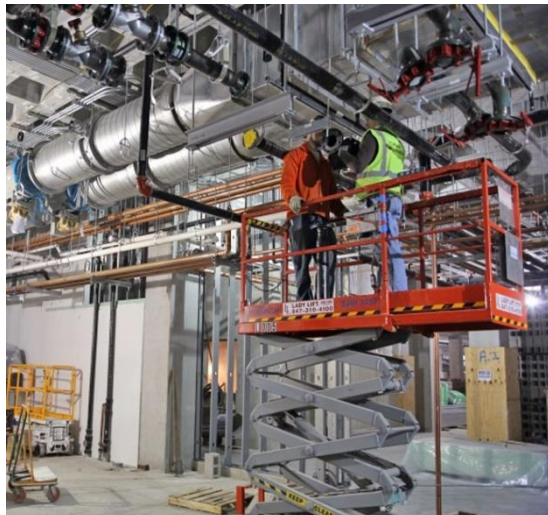
התקנת מערכות אוורור. המקור: The University of Chicago. Facilities services. https://facilities.uchicago.edu/construction//meb
