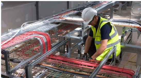
התקנת מערכות חשמליות. המקור: Mace Group. Mechanical, Electrical and Public Health.
