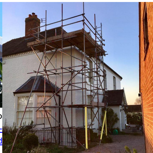
Horizon Scaffolding & Roofing Services. המקור: פיגום תפיסה.
