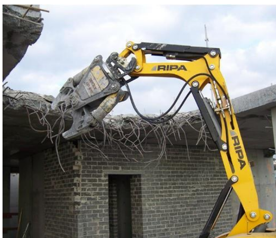
הריסה באמצעות כלים הידרוליים. המקור: IndiaMart https://www.indiamart.com/proddetail/site-demolition-service-10541700355.html
