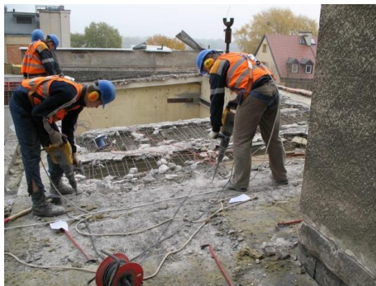
הריסת מבנה ידנית. המקור: Konkret. http://www.konkret.info.pl/en/o,14,Manual_demolition_and_disassembly.html
