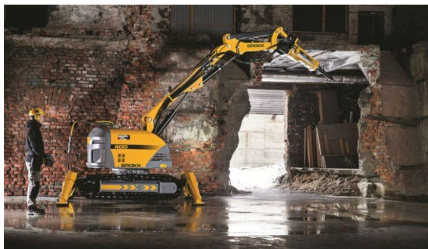
הרסת מבנה באמצעות רובוט. המקור: David Wayne. Global Remote Controlled Demolition Robots Sales Market 2017 – Brokk AB, Husqvarna, Conjet AB. Epress Release. Feb. 2018. https://www.epressrelease.org/global-remote-ctrlled-demolition-robots-sales-market-2017-brokk-ab-husqvarna-conjet-ab/
