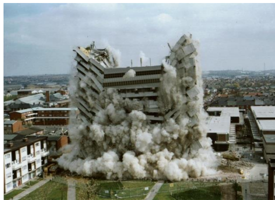
הרסת מבנה באמצעות פיצוץ. המקור: Cowee Home Help. Demolition Service in Manchester. http://www.cowee-elementary.org/demolition-the-essentials/
