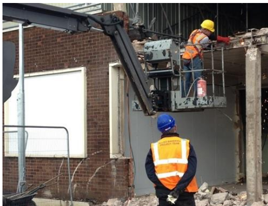
הריסת מבנה ידנית. המקור: RVC Demolition. https://www.rvc-demolition.co.uk/manual-demolition.php
