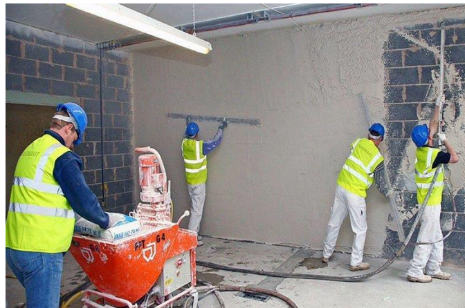
עבודות טיח עם מכונת התזה, כולל הכנת תערובת של טיח כחלק מהתהליך. מקור התמונה: Design Decor. Mechanized plaster for walls: the pros and cons. https://en.aviarydecor.com/4437-mechanized-plaster-for-walls-the-pros-and-cons.html
