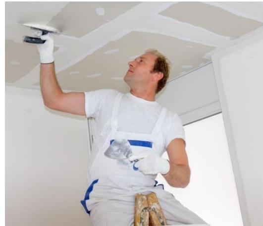
עבודת טיח ידנית. מקור התמונה: Reardon Plastering Pty Ltd. Plastering Renovation. https://www.reardonplastering.com.au/plasterer.php
