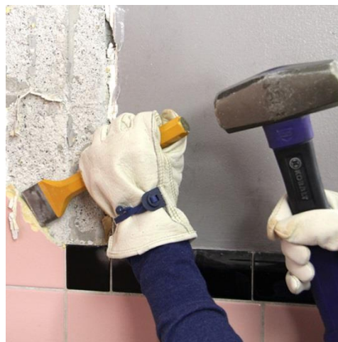
הורדת אריחים ישנים מקיר. מקור התמונה: Lowe's. Prep for Shower Wall Tile.
