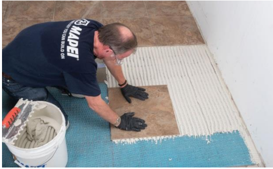
מקור התמונה: Floor Trends. Installing Large-Format Ceramic Tile: Understanding Prep, Products.
