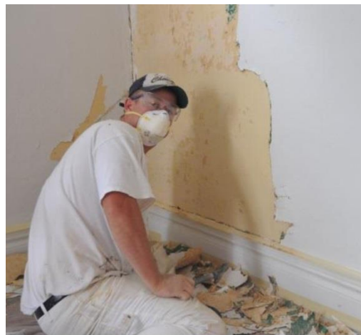
הורדת טפטים ישנים. מקור התמונה: Wallpaper Safari. Removing old wallpaper. https://wallpapersafari.com/
