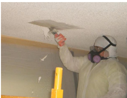
הורדת ציפוי "פופקורן" מכיל אסבסט מהתקרה. מקור התמונה: AWM Asbestos and Meth Removers. Popcorn Ceiling Removal. http://awm.co.nz/
