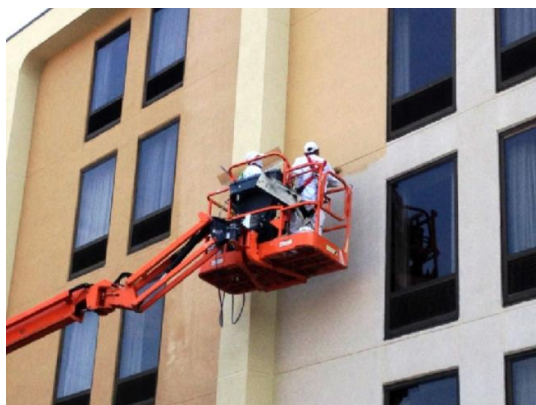
צביעה תוך שימוש בסל הרמה. מקור התמונה: Green E Built. Commercial Painting – by Green E construction. Apr 14, 2017. https://greenebuilt.com/
