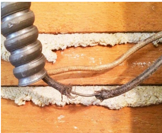
חוטי חשמל מתחת לטיח ישן. מקור התמונה: Gary Wentz. Family Handyman. Plaster and Lath-Tear Off Tips. https://www.familyhandyman.com/
