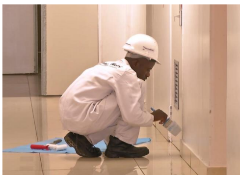
צביעה במברשת. מקור התמונה: Coating Workx. Painting Contracting Services. https://www.coatingworx.co.za/
