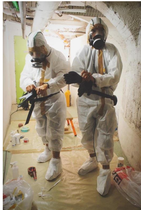
הכנה לצביעה במקום מוקף. מקור התמונה: Performance Painting Contractors, Inc. The Unique Challenges of Painting Confined Spaces. https://www.performance-painting.com/
