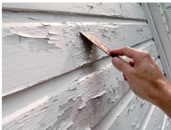
הורדת צבע ישן מהקיר. מקור התמונה: DIY Network. 10 Things You Must Know When Painting a House Exterior. Photo by Dennis Oblander. https://www.diynetwork.com/
