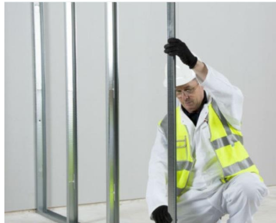
התקנת מסגרת למחיצת גבס. מקור התמונה: KNAUF. Drywall System. Partition System. https://www.knauf.co.uk/
