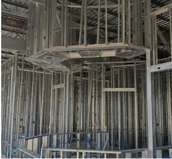
מסגרת פלדה להתקנת לוחות גבס. מקור התמונה: American Craftsmen Inc. Metal Framing & Drywall. https://www.americancraftsmeninc.com/
