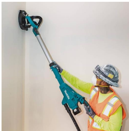
שיוף קיר לאחר התקנת לוחות גבס. מקור התמונה: ProTool Reviews. Makita Cordless Drywall Sander XLS01T and XLS01Z. https://www.protoolreviews.com/
