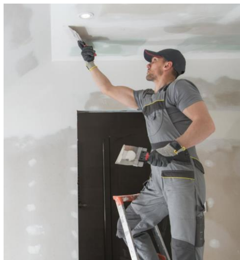
איטום חורים וחריצים בקירות ותקרת גבס. מקור התמונה: Drywall Services Lakewood CO. https://www.lakewooddrywall.com/
