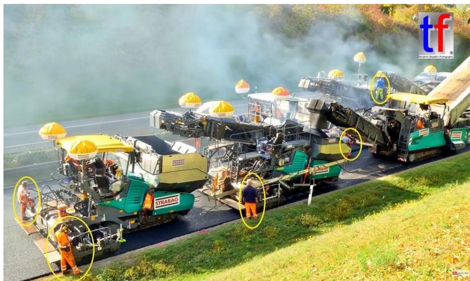
סלילת אספלט חם, העובדים נמצאים בקרבת המכונות שפועלות בתנועה
