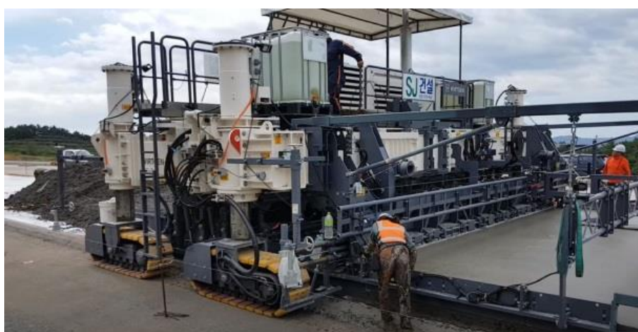
워니TV. SP-1200(Wirtgen) 콘크리트포장 시공 Slipform Pavers. מקור התמונות: YouTube. September 2016. https://www.youtube.com/
