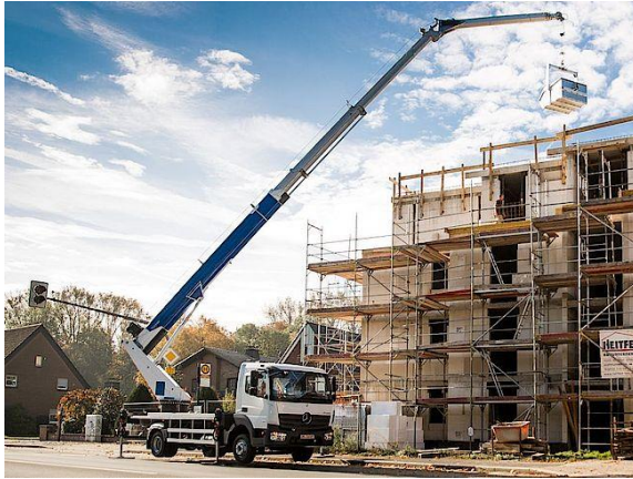
עגורן נייד מותקן על משאית קלה. מקור התמונה: Track Crane. – עגורן נייד – http://www.clift.co.il/
