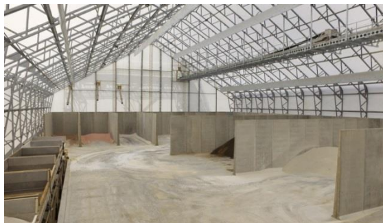
אחסון דשנים בתפזורת. מקור התמונה: Greenstone Construction. Dry fertilizer storage warehouse.
