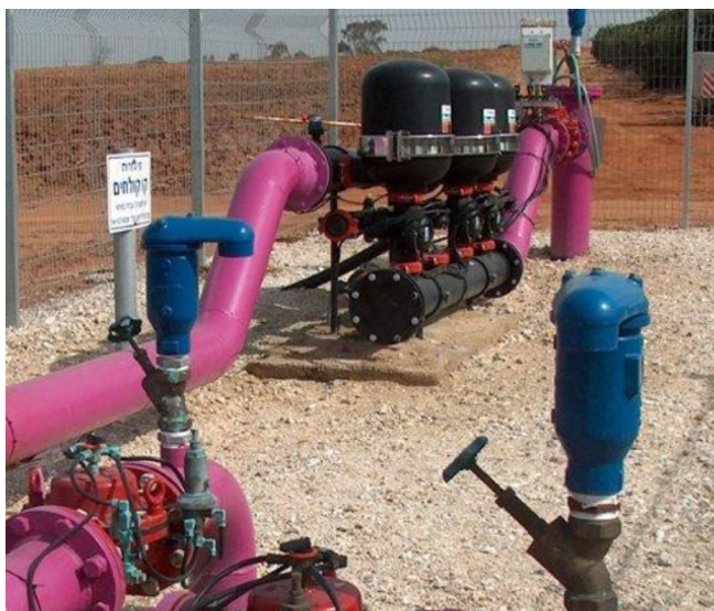
מערכת הולכה למי קולחין. מקור התמונה: חברת בנייה רימון. פרויקט מערכות השבת מים לשימוש חקלאי. http://rimonltd.israelweb.co.il/
